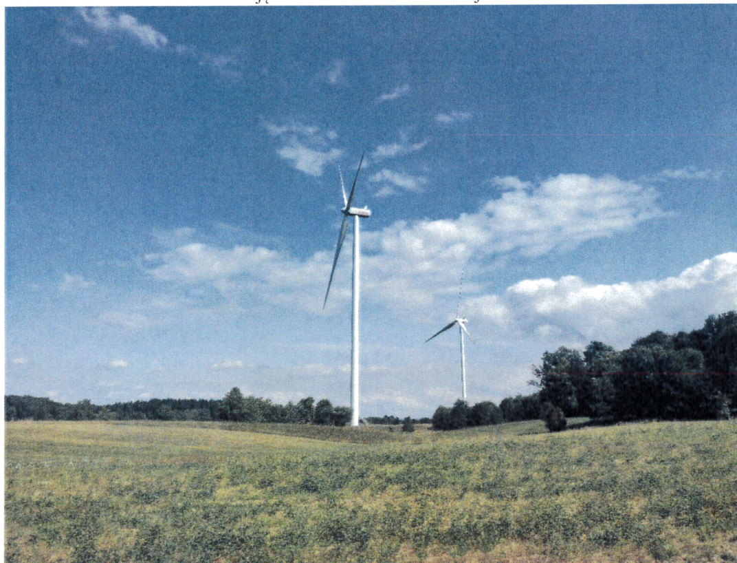
Zdjęcie nr 2. Widok na FW Majewo.
