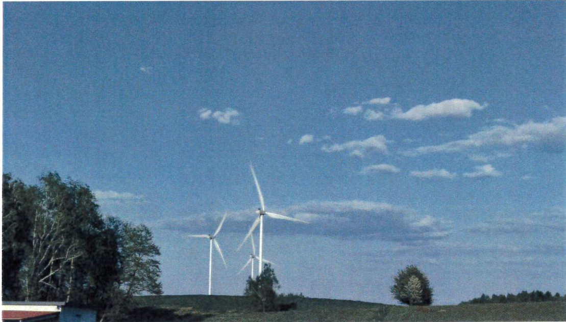
Zdjęcie nr 1. Widok na FW Majewo.
